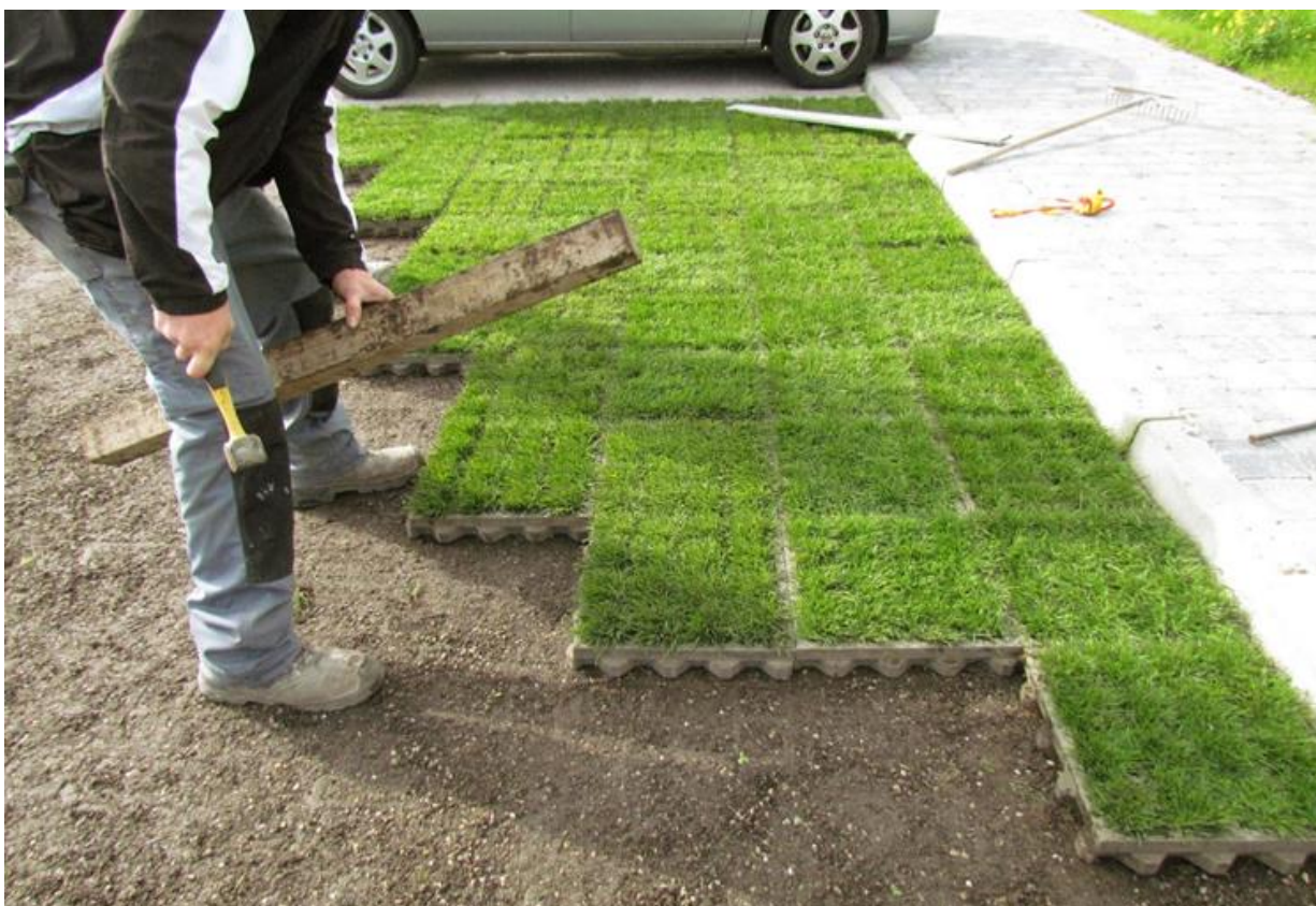
Umožnit zasakování vody a snížit přehřívání lze i na parkovištích. Realizace zatravněné zasakovací dlažby. Foto: Asio, spol. s.r.o.
